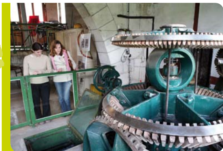
Pavillon de Manse. © D. Grouard, PNR OPF.
